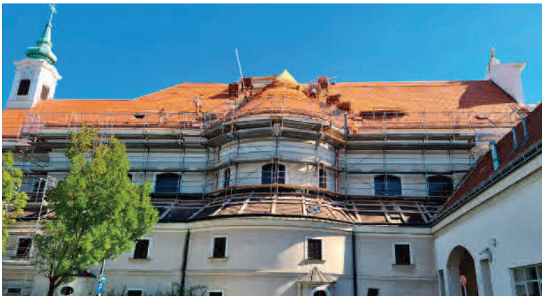
Die letzten Ziegel werden angebracht.
